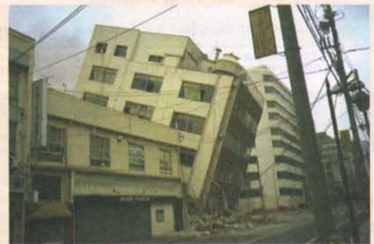
Последствия землетрясения в Кобе (Япония) 1995 г.
