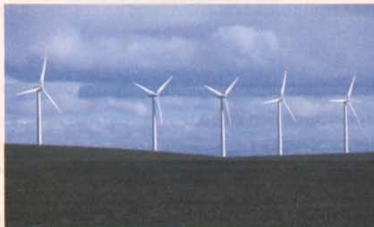
Вращение пропеллеров электростанции
